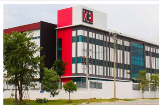
NHÀ MÁY XP POWER - BÌNH DƯƠNG
