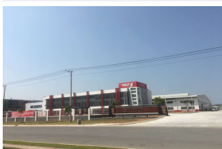
NHÀ XƯỞNG YAO I (KCN VISIP 2A)
