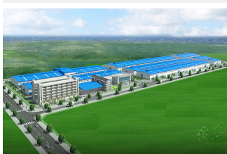
NHÀ MÁY RITAR POWER (Tây Ninh)
